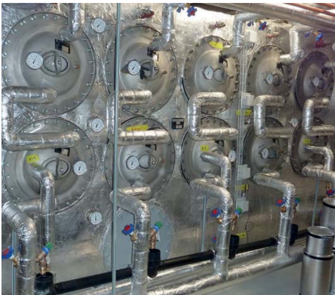
Beispiel eines fertig verbauten «Kubischen Speichers».
