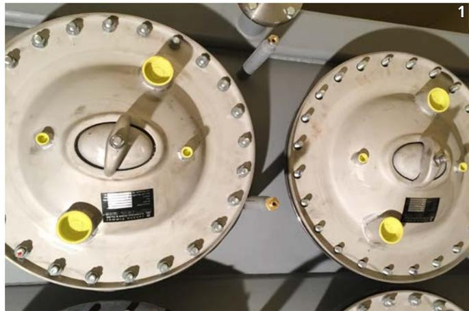
ren. Im Heizwasserspeicher sind neun horizontale Wassererwärmer aus Edelstahl eingebaut (Bilder 1 und 2). Zusammen hat das Hotel mit integriertem Restaurant einen täglichen Warmwasserbedarf von 15'000 Litern mit Stundenspitzen von bis zu 3'075 Liter. Die Energiezufuhr erfolgt hauptsächlich über eine Wasser-Wasser Wärmepumpe. Ergänzend wird die Abwärme der Gewerbekälte
